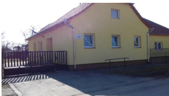
Hadház úti óvoda
